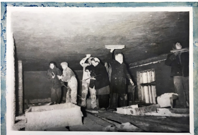
1959 год. Отделка пристроя.
